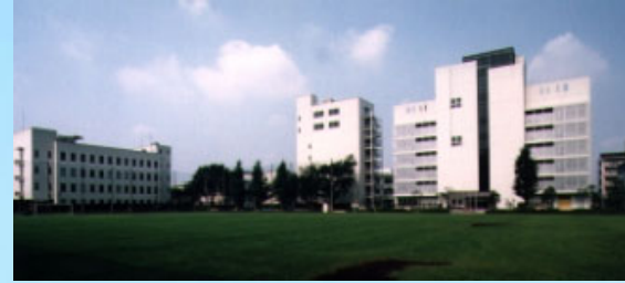
教育センター 三菱電機ビルテクノサービス
